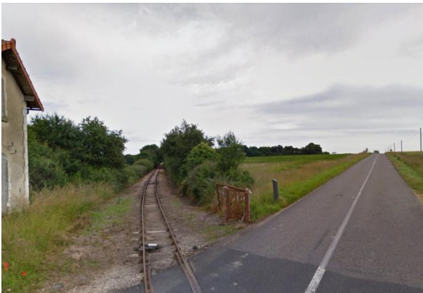
Vue de la ligne ferroviaire touristique vers l'est (repère 5)
